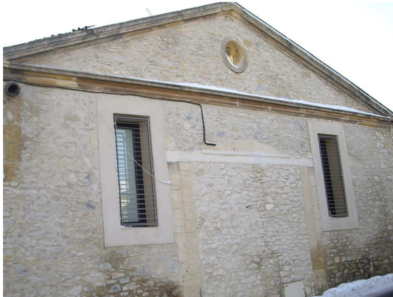
L'actuelle façade de l'école qui était un ancien moulin
