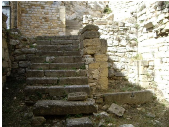
Escalier qui mène au pressoir
